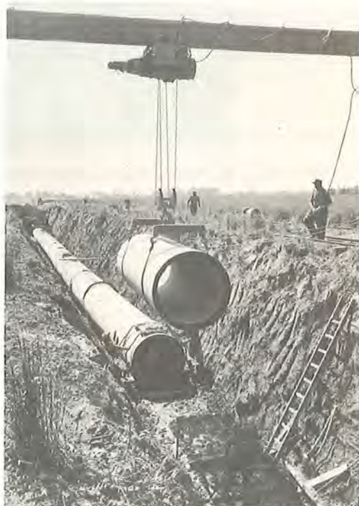
Fig. 178 Lægning af rør ved hjælp af portalkran (59)
