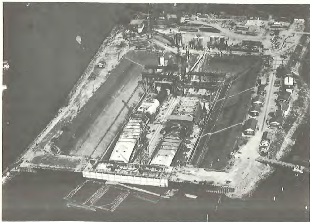
Fig. 152 Tørdok til bygning af tunnelelementer (43)
