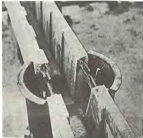
Fig. 118 Elementmontage. Samlingen danner selv form for udstøbningen (21)
