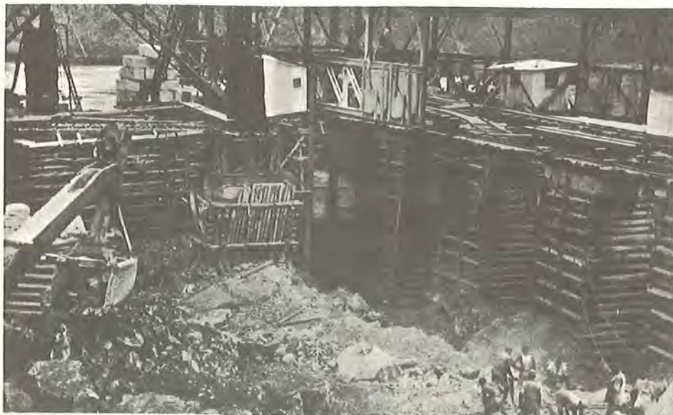
Fig. 139 Tørslagt byggegrube ved Owen Falls (18)
