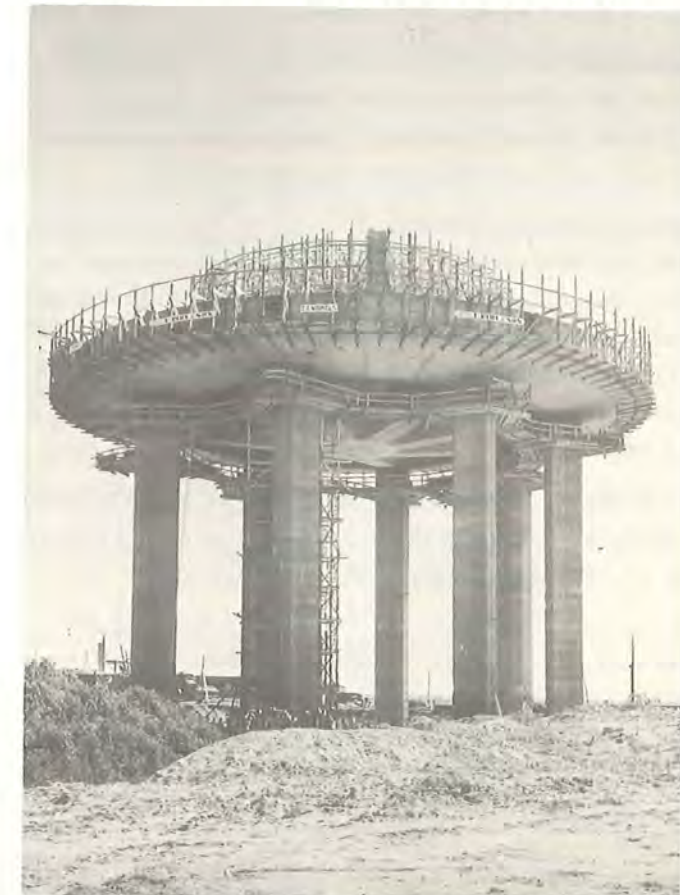
Fig. 180 Løftning af vandbeholder. Vandtårn i Roskilde (71)
