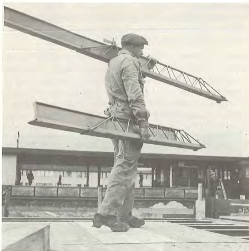
Fig. 83 Stålgitterdragere med regulerbar længde (64)
