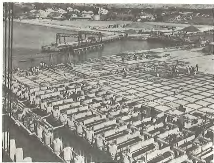
Fig. 167 Udførelse af åben pier (45)
