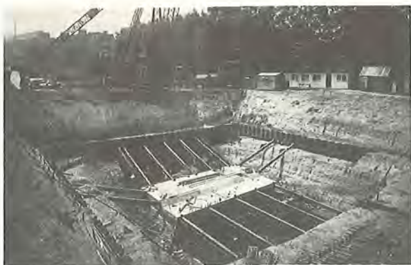
Fig. 134 Afstivning af spunsjernsindfatning (31)
