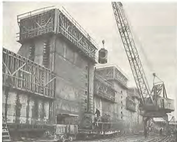
Fig. 175 Bygning af massiv grovbetondæmning (8)
