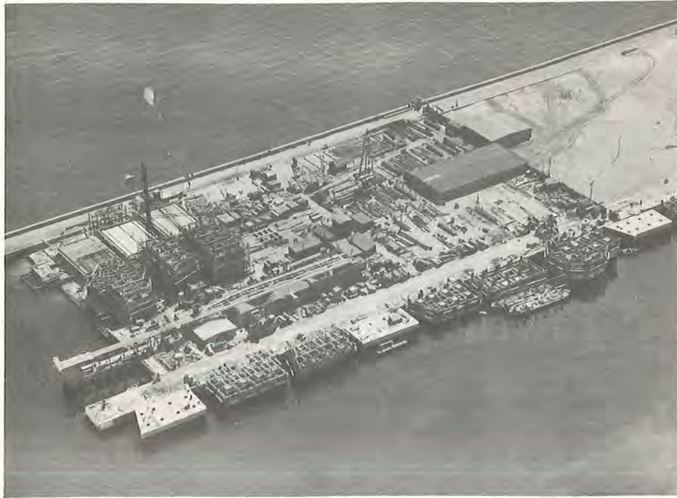
Fig. 68 Støbning af sænkekasser på bedding (57)
