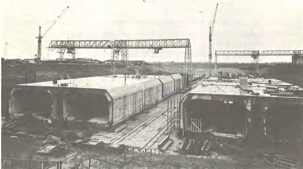
Fig. 153 Bygning af tunnelelementer (43)
