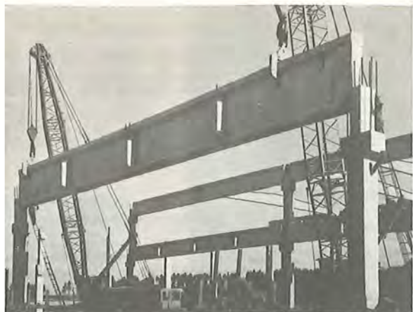
Fig. 115 Elementmontage med 2 mobilkraner (52)
