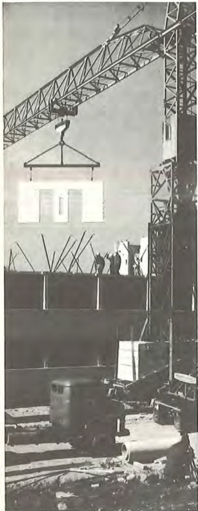
Fig. 113 Elementmontage med tårndrejekran (60)
