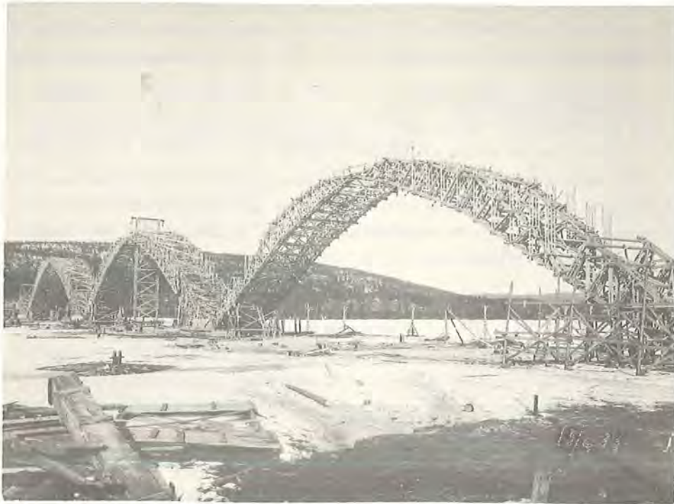
Fig. 140 Buestillads til bro over Ångermanälven ved Hammar (57)
