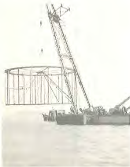
Fig. 136 Udførelse af pille inden for fangedæmning (29)
