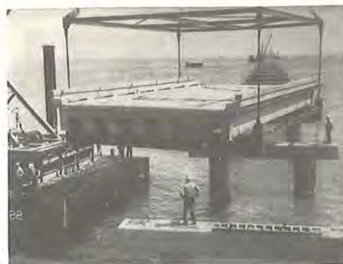
Fig. 144 Præfabrikeret bro på pæleåg (29)
