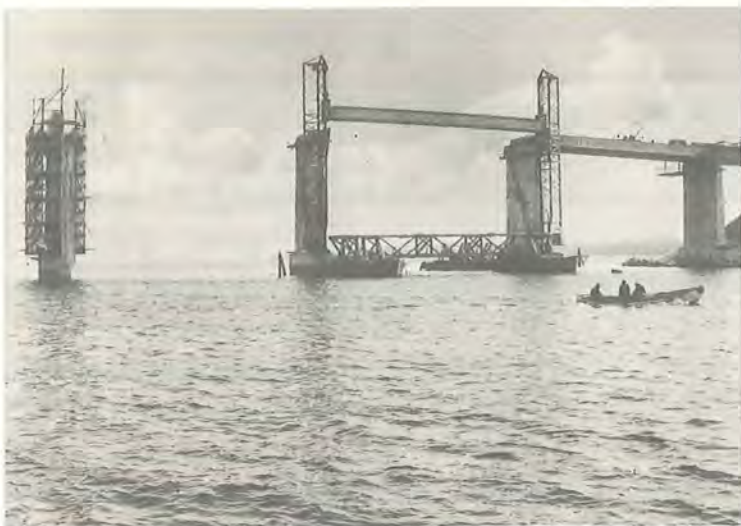
Fig. 146 Montage af præfabrikerede brobanebjælker (58)
