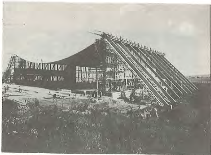
Fig. 121 Skalkonstruktion i efterspændt beton (58)
