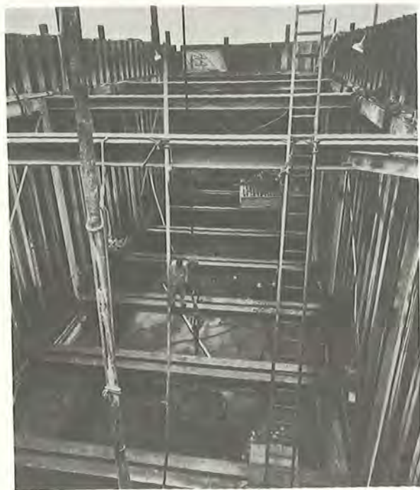
Fig. 133 Byggegrube med stålafstivning (45)
