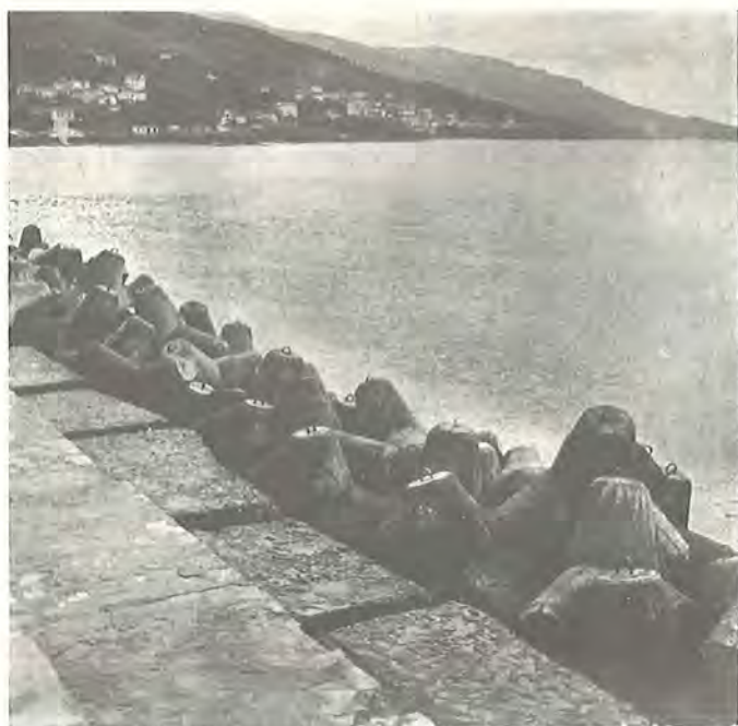
Fig. 157 Stenkastning af tetrapoder (36)
