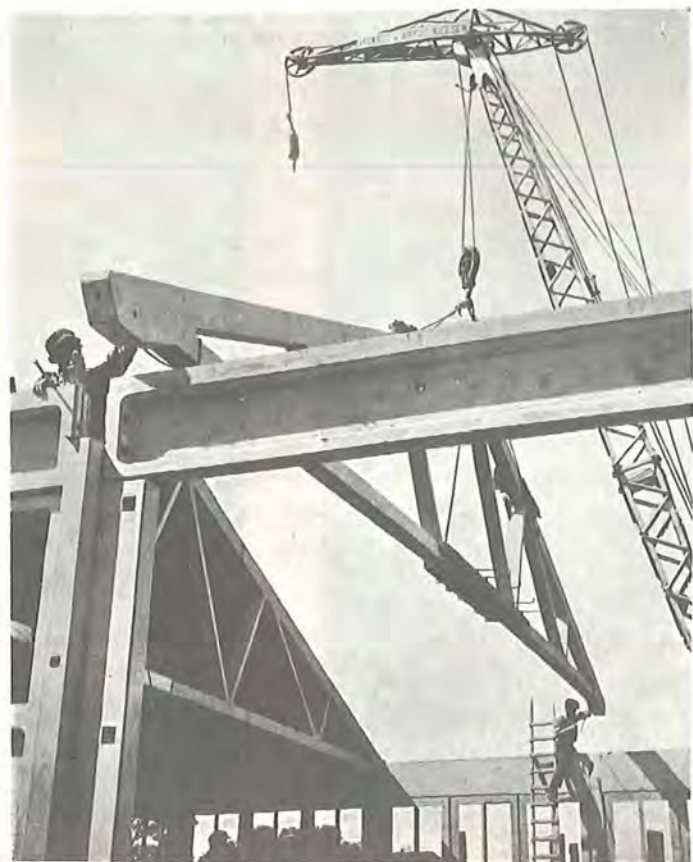
Fig. 116 Samling af betonelementer med bolte (21)
