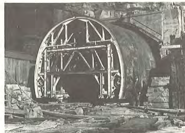
Fig. 78 Køreform til tunnelforing (31)
