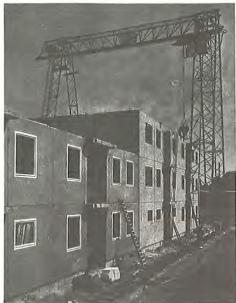
Fig. 114 Elementmontage med portalkran (49)
