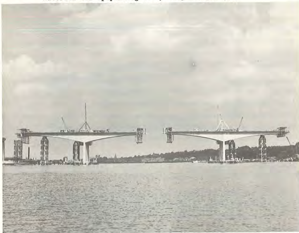
Fig. 127 "Fri frembygning" med sektioner udstøbt in situ og med hjælpestillads (57)
