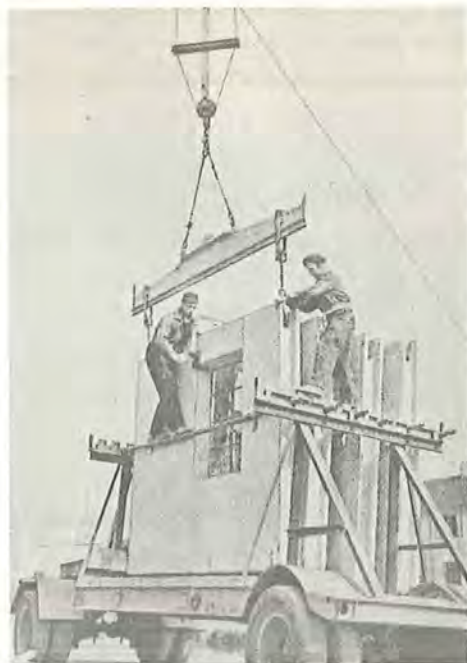
Fig. 112 Transport af betonelementer på reolvojn (21)
